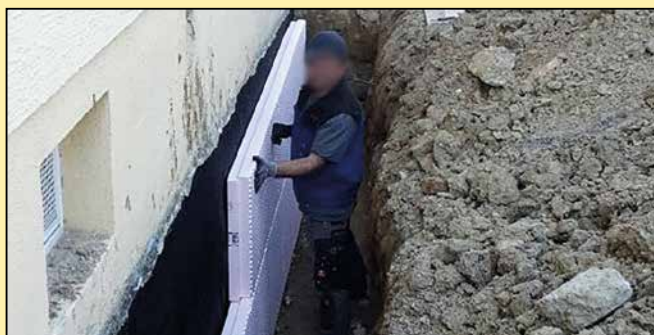
Schutzanstrich-Bitumenspachtelung-Perimeterdämmung
