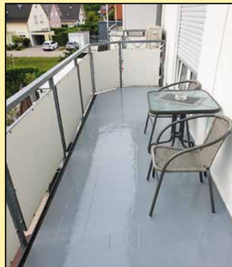
Balkone und Terrassen nachher, Abdichtung in hellgrau
