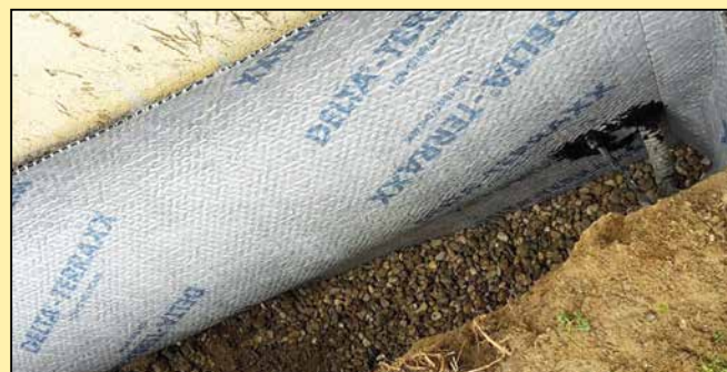
Noppenbahn mit Drainagefließ, Kiesbett am Grund
