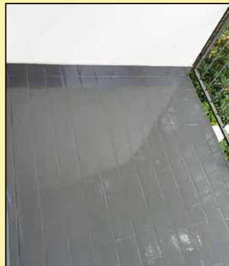
Balkone und Terrassen, Abdichtung in anthrazit
