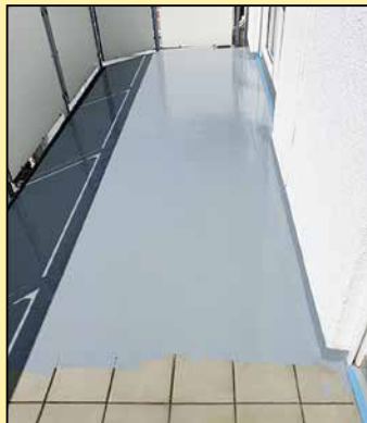
Balkone und Terrassen vorher
